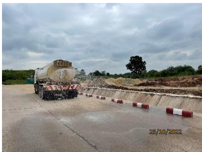
รูปที่ 2-9 การฉีดพรมน้ำเพื่อลดการฟุ้งกระจายของฝุ่นละอองภายในพื้นที่โครงการ
