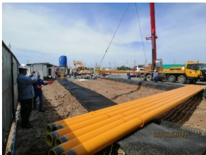
รูปที่ 2-64 การจัดเก็บท่อฯ อย่างเป็นระเบียบ
