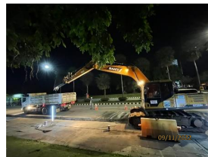
รูปที่ 2-39 การกั้นเขตพื้นที่ และป้ายเตือน ขณะเครื่องจักรกลกำลังปฏิบัติงาน
