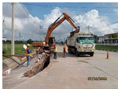
รูปที่ 2-7 การขุดเปิดหน้าดินสำหรับวางท่อเท่านั้น
