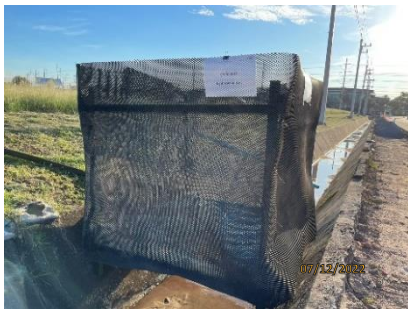
รูปที่ 2-34 การติดตั้งตะแกรงหรือตาข่าย เพื่อดักตะกอนก่อนระบายน้ำทิ้ง
