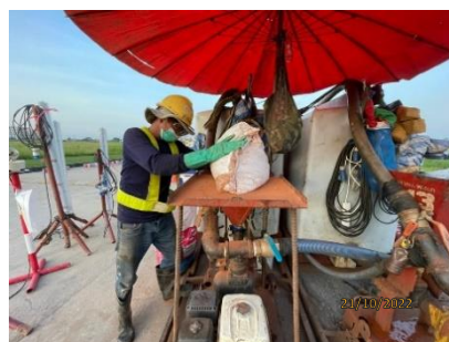
รูปที่ 2-44 การผสมผงโซเดียมเบนโทไนท์
