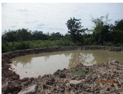
รูปที่ 2-46 พื้นที่สำหรับทิ้งโคลนโซเดียมเบนโทไนท์
