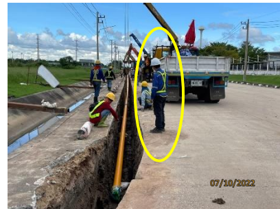
รูปที่ 2-63 การกันพื้นที่ และเจ้าหน้าที่ควบคุม บริเวณที่มีการยกท่อ
