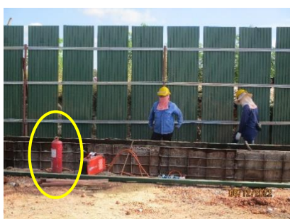
รูปที่ 2-54 การเตรียมถังดับเพลิง สำหรับงานที่ก่อให้เกิดประกายไฟ
