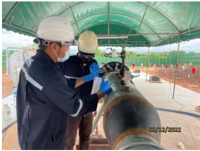
รูปที่ 2-33 การติดตามตรวจสอบคุณภาพน้ำทิ้งจากการทดสอบท่อด้วยวิธี Hydrostatic Test
