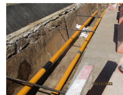
รูปที่ 2-21 การติดตั้งอุปกรณ์ป้องกันดินถล่มบริเวณร่องชุด
