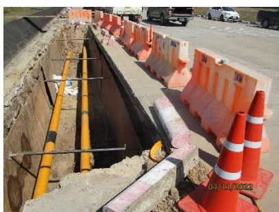
รูปที่ 2-21 การติดตั้งอุปกรณ์ป้องกันดินถล่มบริเวณร่องชุด
