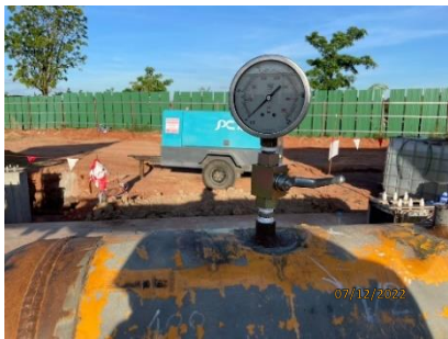
รูปที่ 2-35 การปรับลดแรงดันจากการทดสอบท่อด้วยวิธี Hydrostatic Test
