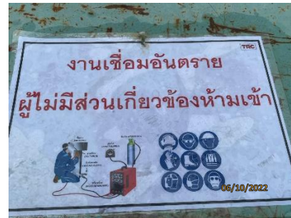
รูปที่ 2-60 การกันเขต และติดป้ายแสดงเขตหวงห้าม บริเวณพื้นที่ที่ทำการเชื่อม
