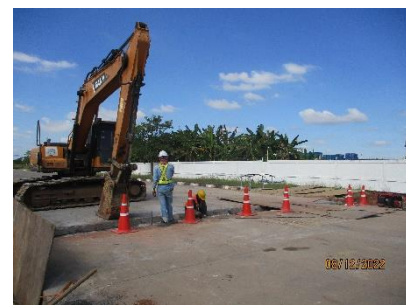
รูปที่ 2-7 การขุดเปิดหน้าดินสำหรับวางท่อเท่านั้น
