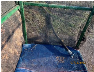
รูปที่ 2-34 การติดตั้งตะแกรงหรือตาข่าย เพื่อดักตะกอนก่อนระบายน้ำทิ้ง
