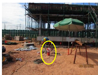
รูปที่ 2-54 การเตรียมถังดับเพลิง สำหรับงานที่ก่อให้เกิดประกายไฟ
